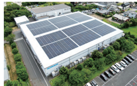
太陽光発電を開始した富津工場
