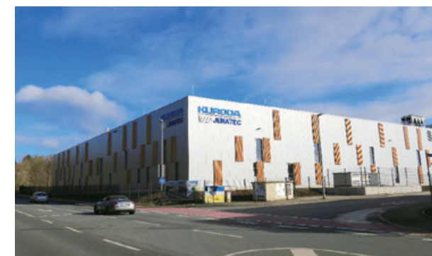
Jenaer Gewindetechnik GmbH新工場
