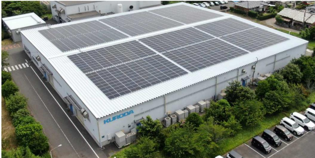
オンサイト自家消費型太陽光発電サービス（PPA モデル/第三者所有モデル）を活用し、富津工場内にある TL 工場棟の屋根スペースを提供し、エネルギーサービス事業者である SMFL みらいパートナーズ株式会社（代表取締役社長：寺田 達朗、本社：東京都千代田区）が容量 565W の高出力太陽光パネルを 874 枚設置しました。パネル容量は 493.8kW となり、発電量は年間 552MWh を見込んでいます。この太陽光発電設備の導入により、CO<sub>2</sub> 排出量を年間約 260t 削減できる見込みです。
